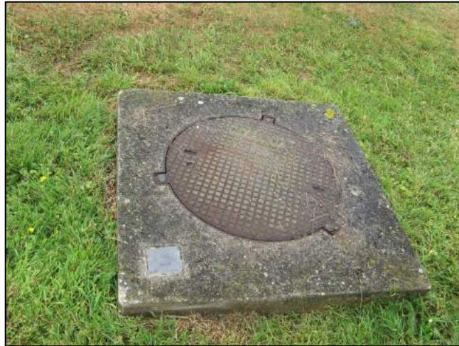
Figure 2 : Localisation du puits 7
