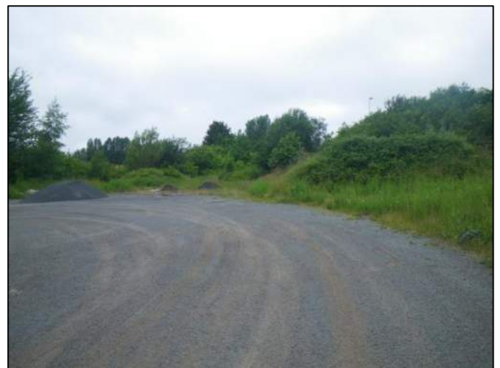
Figure 6 : Vue du terril 18 à proximité de la RD301 au sud-ouest
