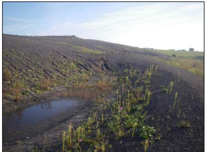
Figure 3 : Vue des bassins de rétention au pied du terril 1
